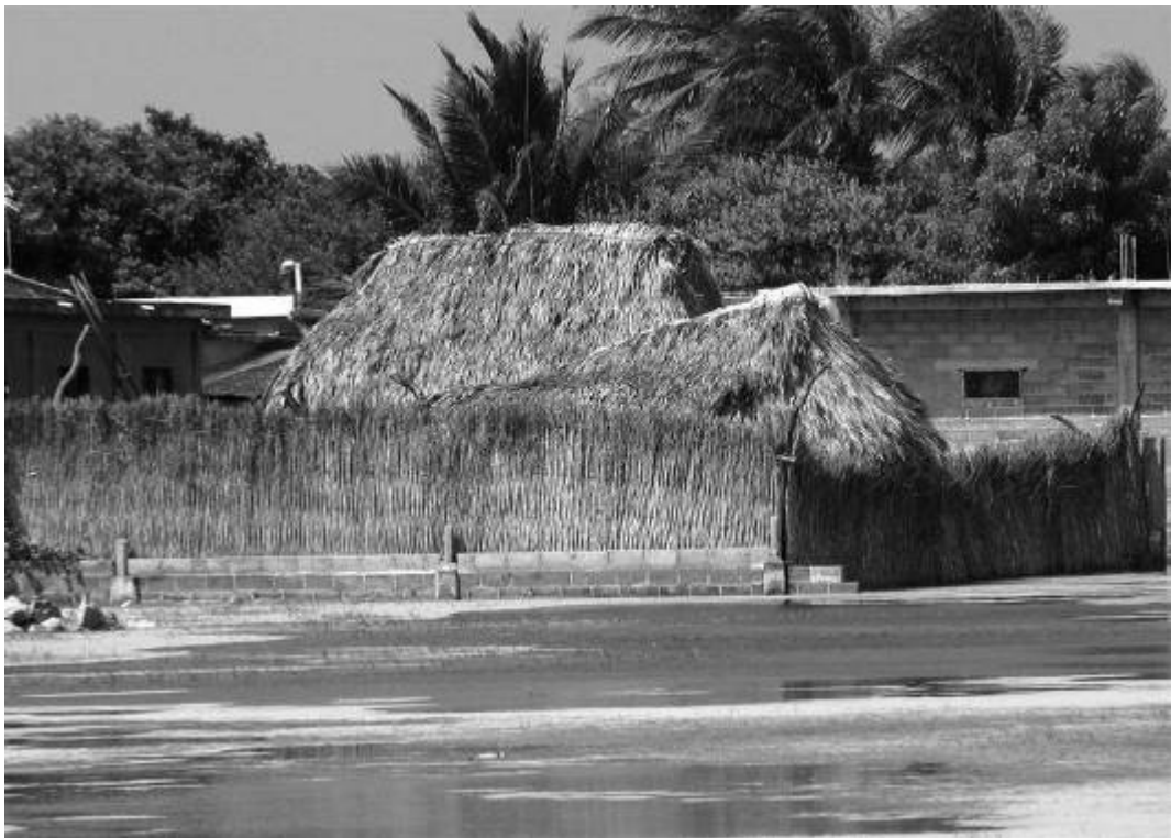
Photo 9. Maison huave protégée de l'inondation avec un barrage des briques. FBG. [2005]
