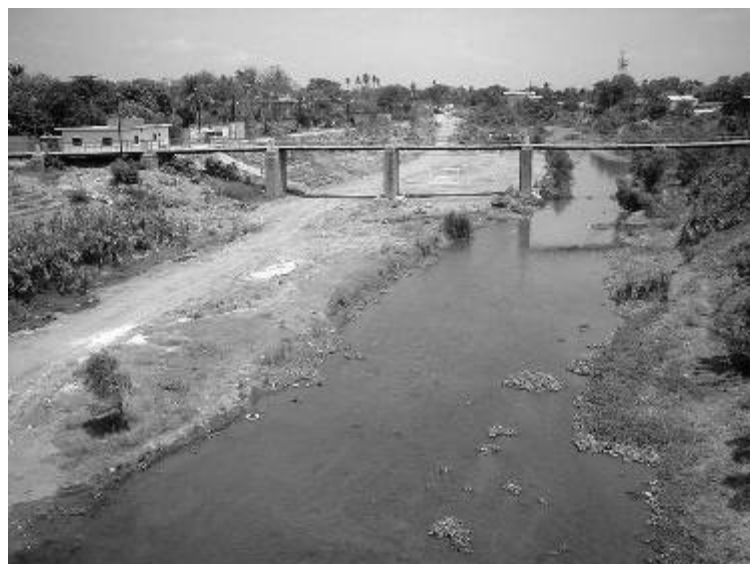
Dépôts des ordures à la rivière Los Perros. Le pont fonctionne comme tampon quand la crue monte. [2004]
