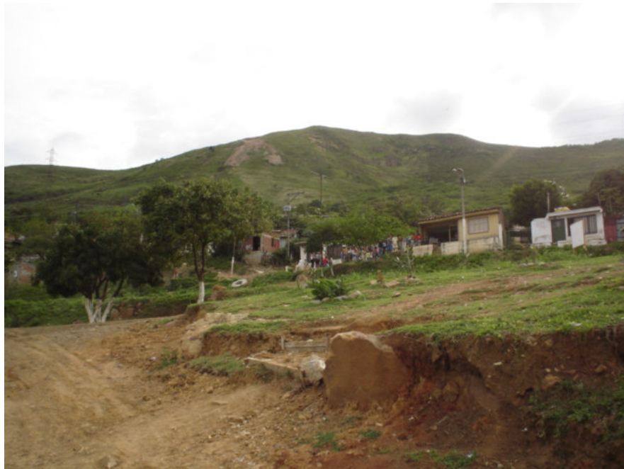
Foto 18. Área desalojada en Nuevo Horizonte (6 manzanas) debido al riesgo que corrían sus moradores.
