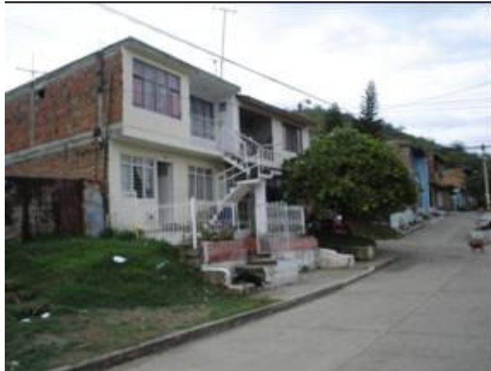
Foto 9. Viviendas modificadas en el barrio Municipal en su mayoría por quienes se vieron afectados por el desastre.
