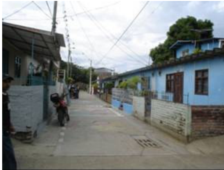
Foto 8. Barrio Municipal, modelo inicial de las viviendas entregadas luego de la inundación de 1974
