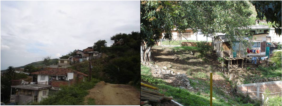
Foto 2 y 3. Asentamientos en sectores con riesgo ligado a deslizamientos y con problemas de alcantarillo, lo cual potencia la amenaza de remoción en masa.
